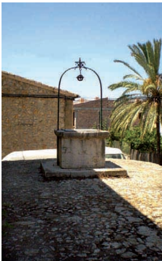
Figura 161. Brocal de extracción de agua del Aljub Vell de Calvià Vila, con mota, cuello, "cintell", travesaños y polea.
