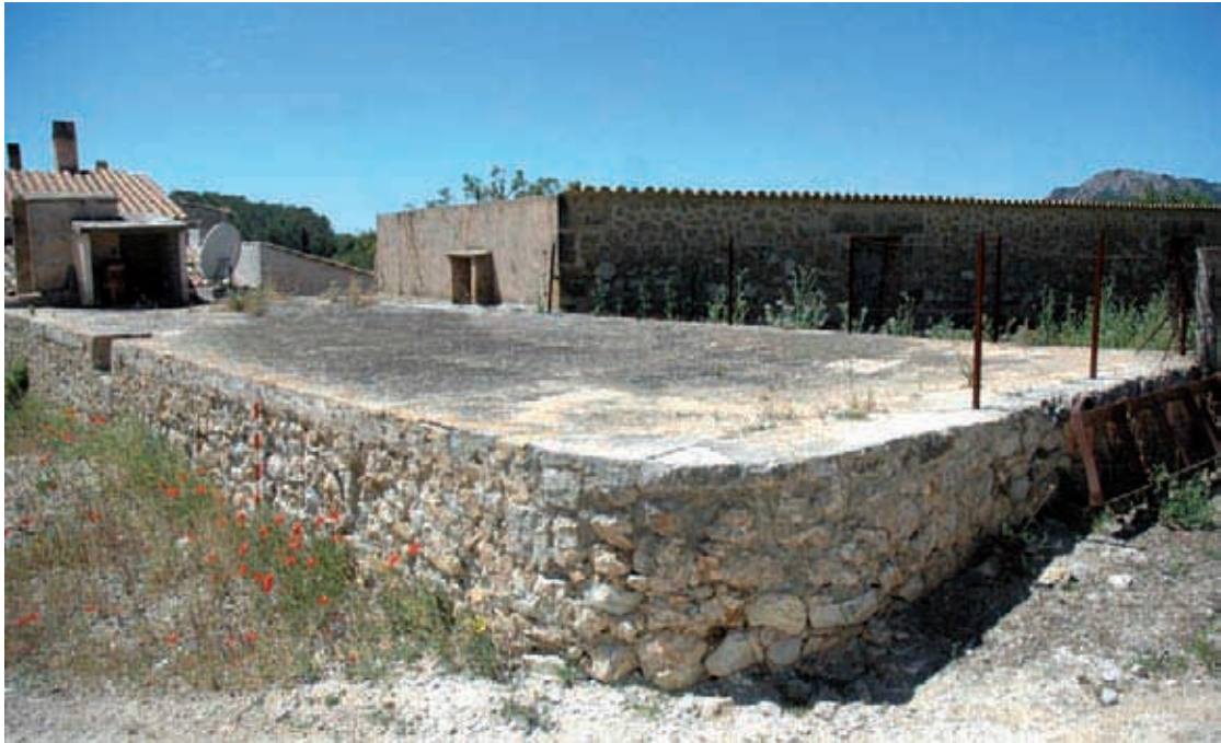
Figura 159. Aljibe con terraza exterior sobre bóveda del sistema hidráulico de Mofarés.
