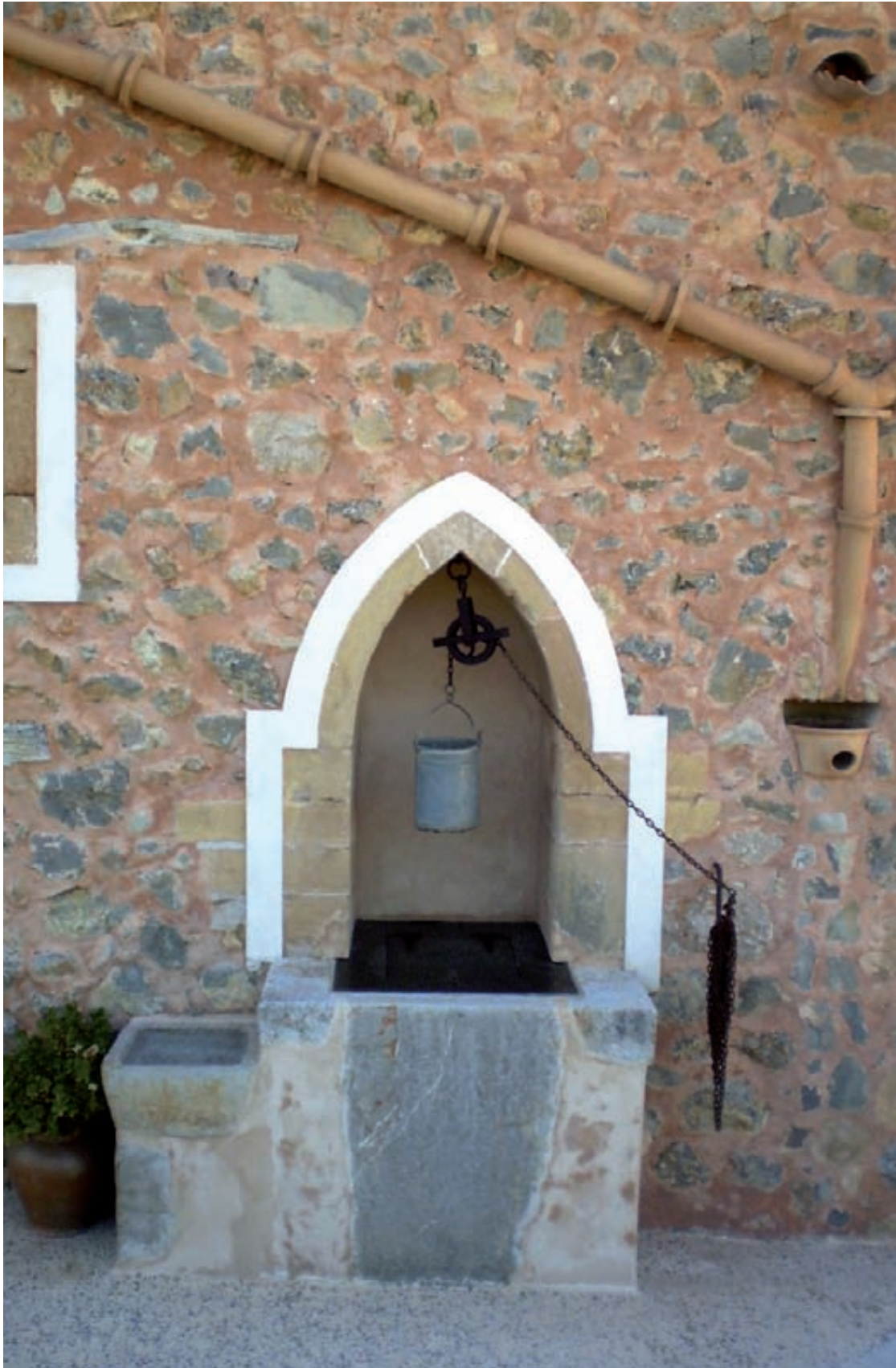
Figura 162. Cisterna de Son Estades, integrada en una de las paredes de las casas.
