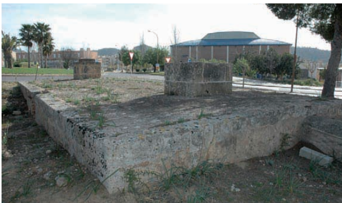
Figura 158. Aljibe de la Urbanización Galatzó.
