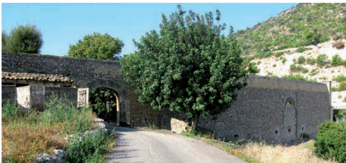
Figura 160. Viaducto por el que discurre la acequia que alimentaba de agua al aljibe de Bendinat.
