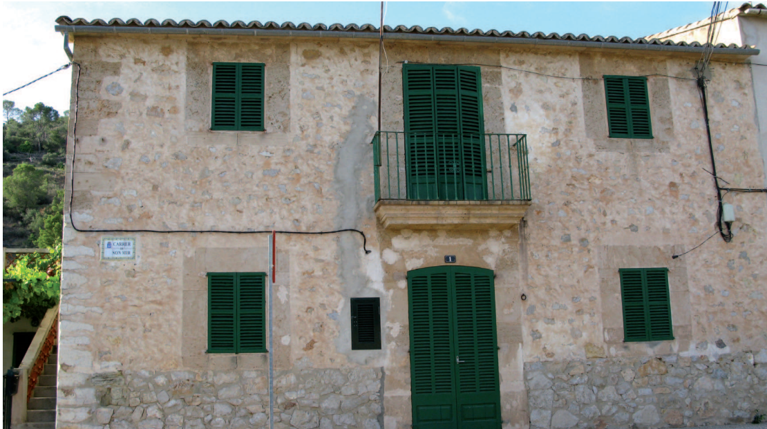
Figura 320. Calle Son Mir nº1. Fachada simétrica de dos pisos, doble crujía y cubierta a doble vertiente. La fachada presenta un doble tratamiento en el acabado, con mampostería vista con junta de mortero amplia y piedra vista a modo de zócalo en el tercio inferior. Los vanos están realizados con sillares regulares y la cadena esquinera con irregulares.
