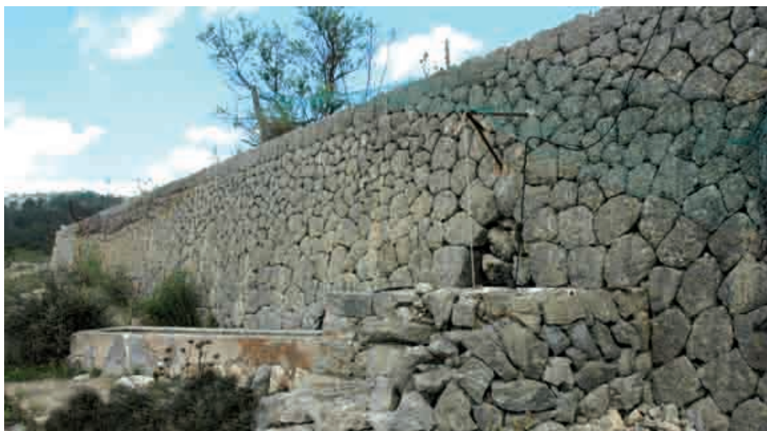
Figura 146. Pozo rural con abrevadero de la "possessió" de Son Roig integrado en una pared seca.
