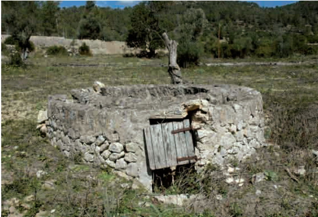
Figura 135. Cuello de gran tamaño con puerta de acceso integrada del pozo de Son Roig Oest.
