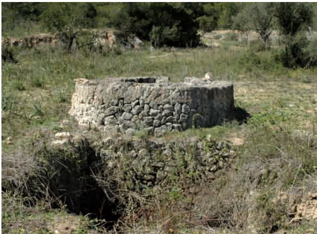
Figura 144. Pou de Son Roig Oest con embalse de almacenamiento adosado.
