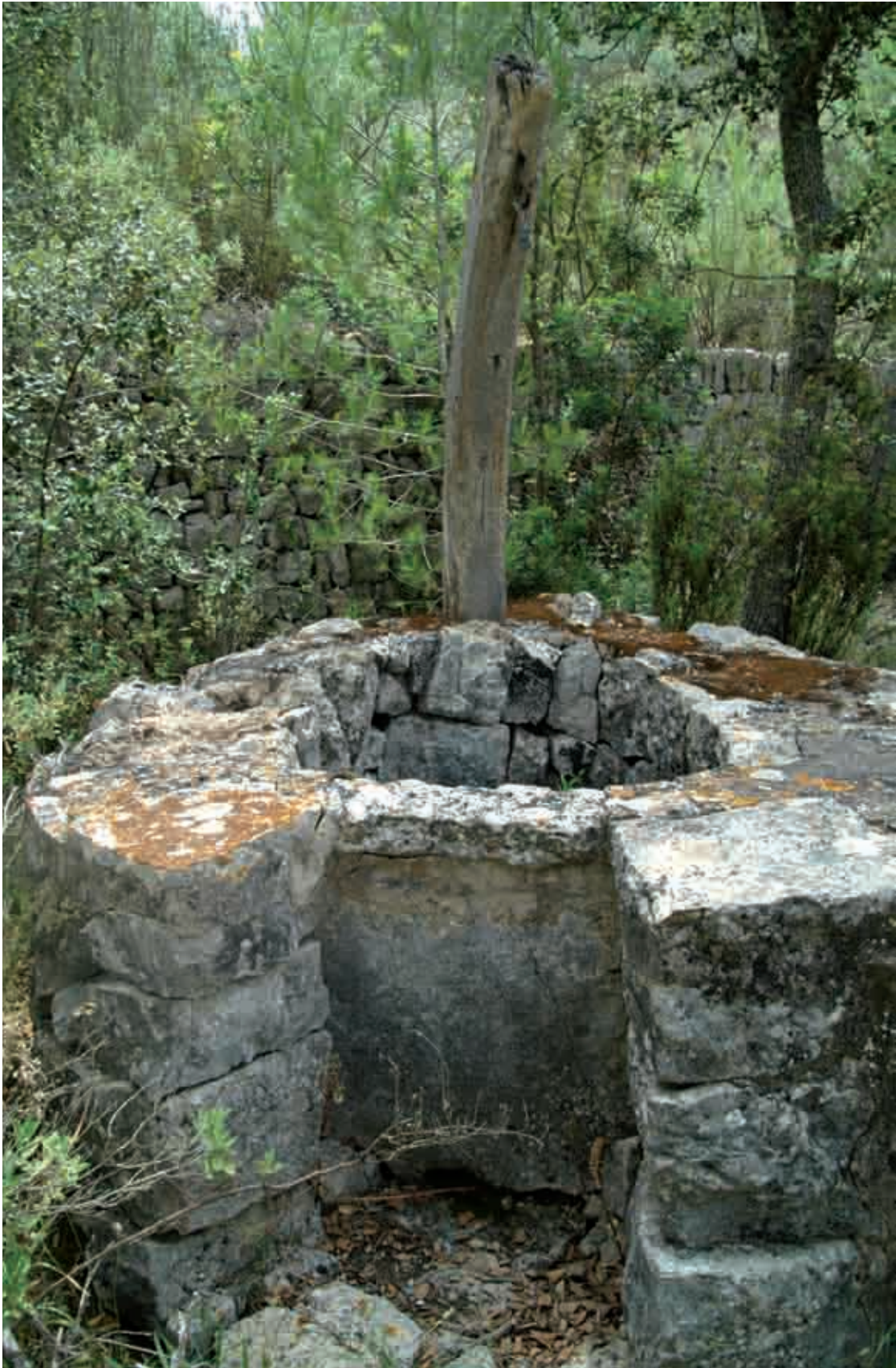
Figura 134. Pozo de la tipología caracterizada por localizar su acceso en el cuello (Pou de sa Cova de Son Boronat).
