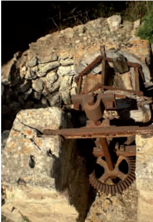
Figura 131. Sinia de Son Alfonso con maquinaria de hierro y madera que conserva los arcaduces y las cadenas.
