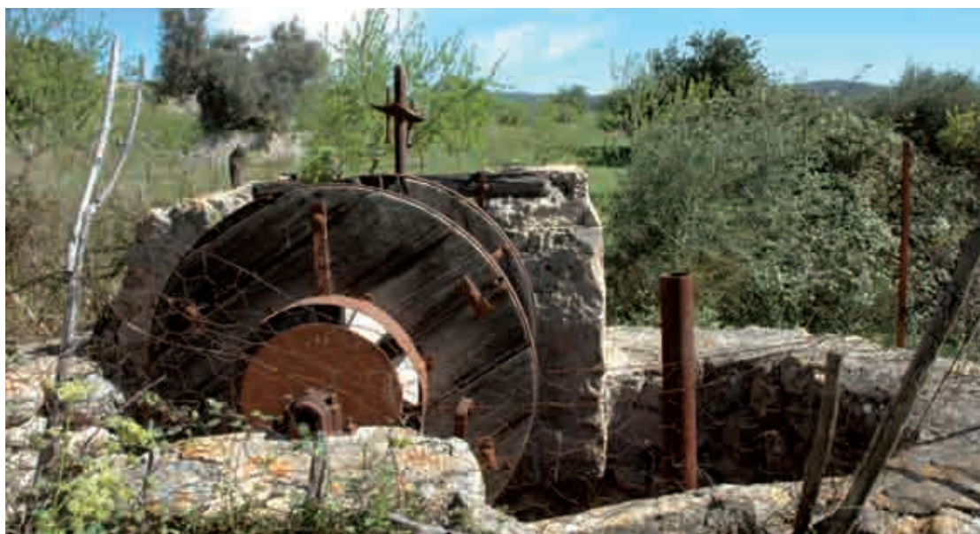
Figura 129. "Sínia" ubicada en la finca de Son Hortolà (Es Capdellà), con maquinaria de hierro y madera.
