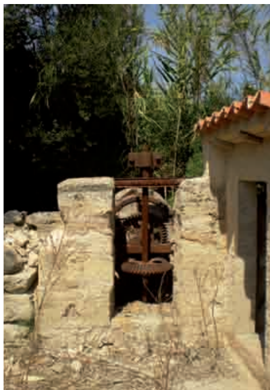
Figura 124. Caseta para resguardar la bomba de extracción y maquinaria metálica (Sínia de Son Alfonso). Fuente: Consell de Mallorca.
