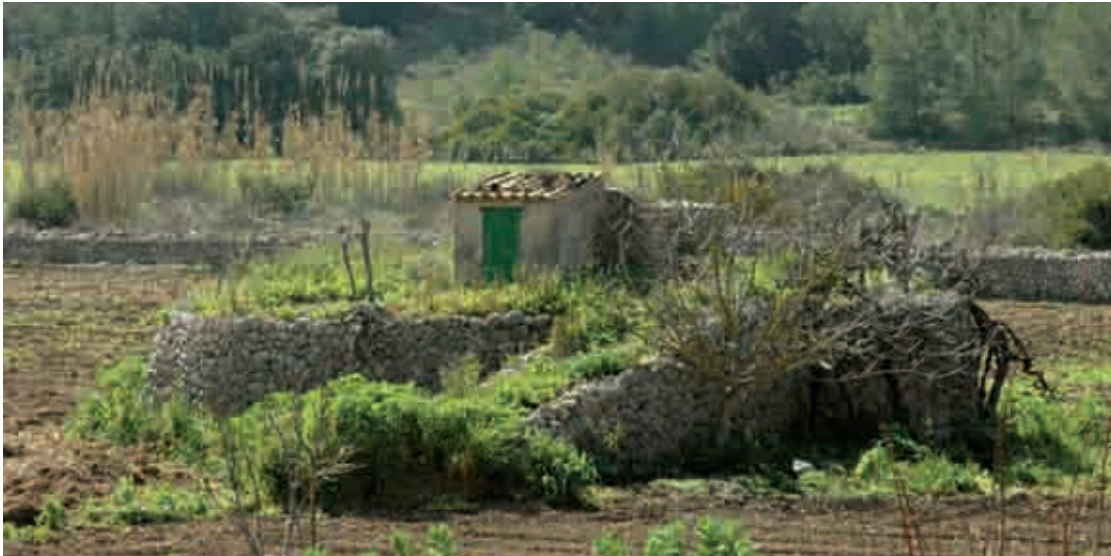
Figura 127. Sínia de Calvià con "cintell", rampa de acceso y caseta para bomba.
