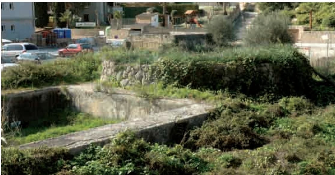
Figura 126. Sínia de Peguera con estanque adosado y caseta para la bomba.
