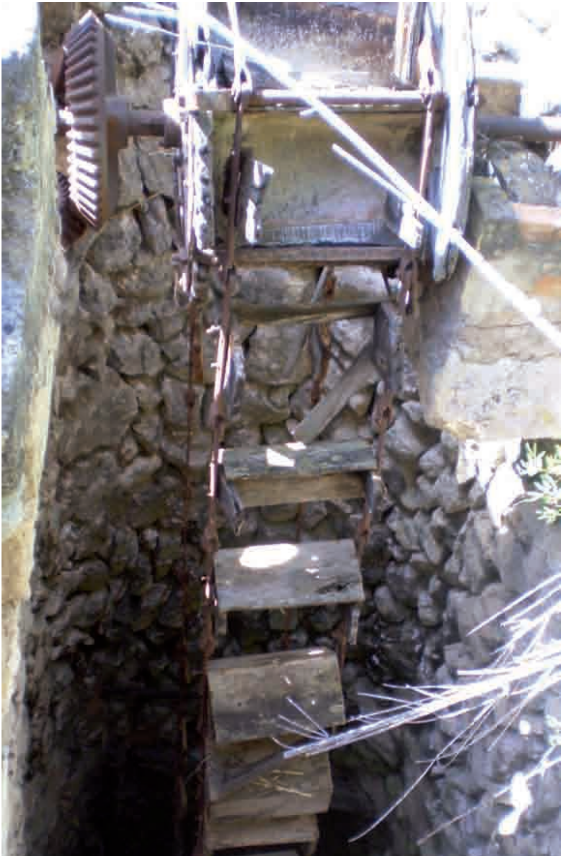
Figura 130. Sínia de Son Alfonso con maquinaria de hierro y madera que conserva los arcaduces y las cadenas.
