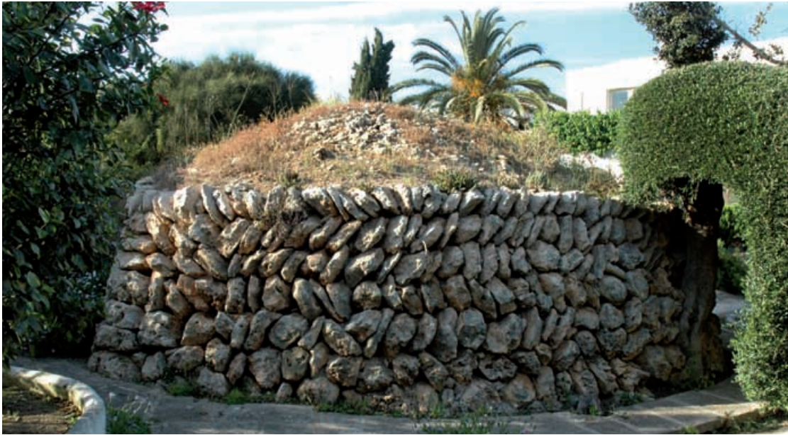
Figura 205. Barraca de Sol de Mallorca. Vista posterior.
