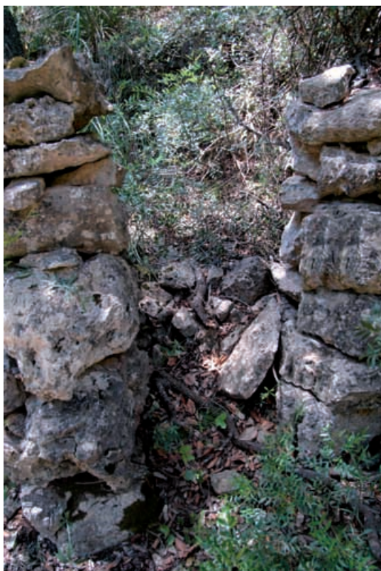
Figura 208. Vano de la barraca de Sa Coma des Bosc Gran (Son Sastre).
