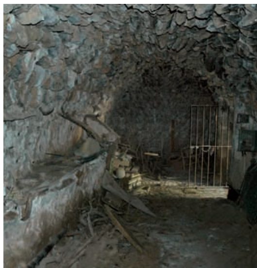
Figura 209. Comedero para animales adosado a uno de los muros interiores de la barraca de Sol de Mallorca.
