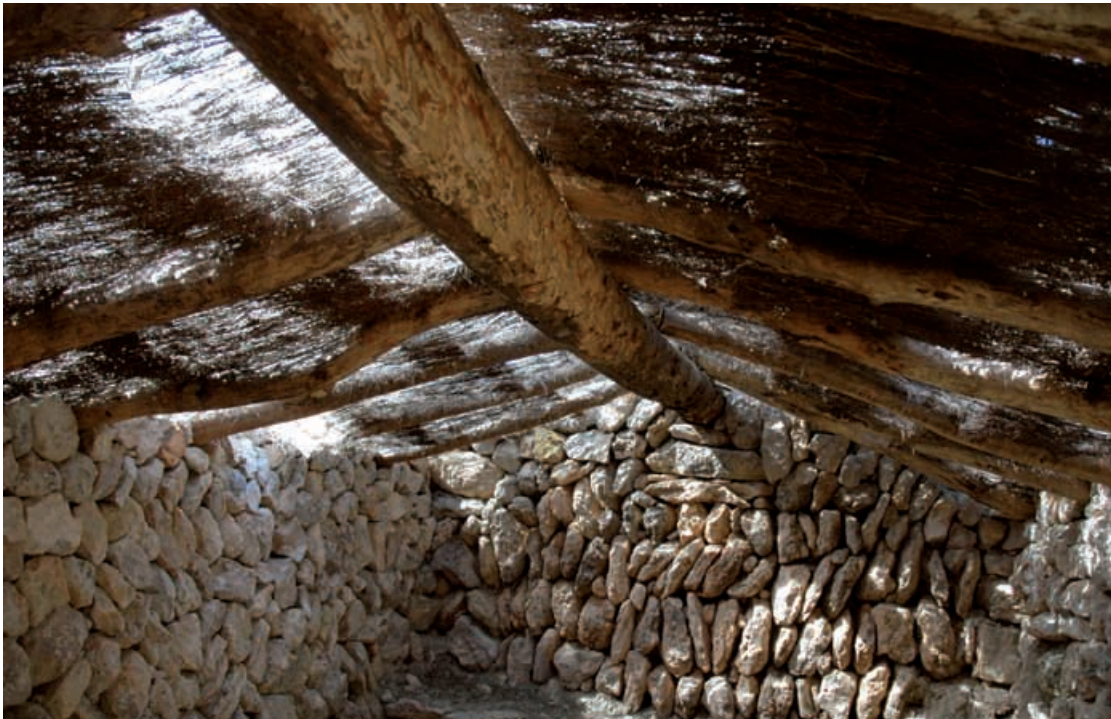
Figura 206. Envigado interior de la barraca de Santa Ponça 20.
