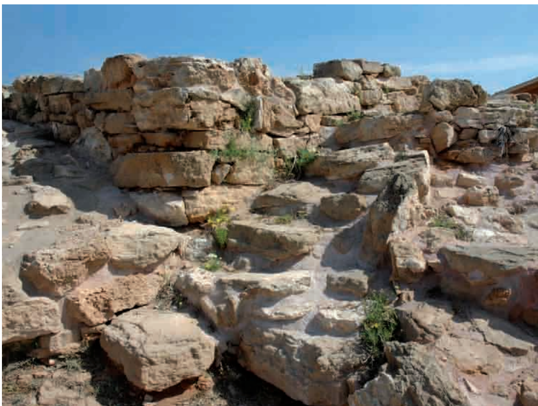
Figura 64. Acceso a la parte superior del Turriforme escalonado de Son Ferrer.
