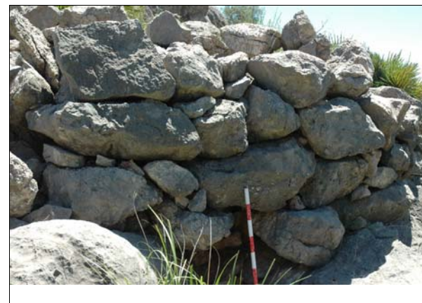
Descripción: Detalle del muro oeste.
